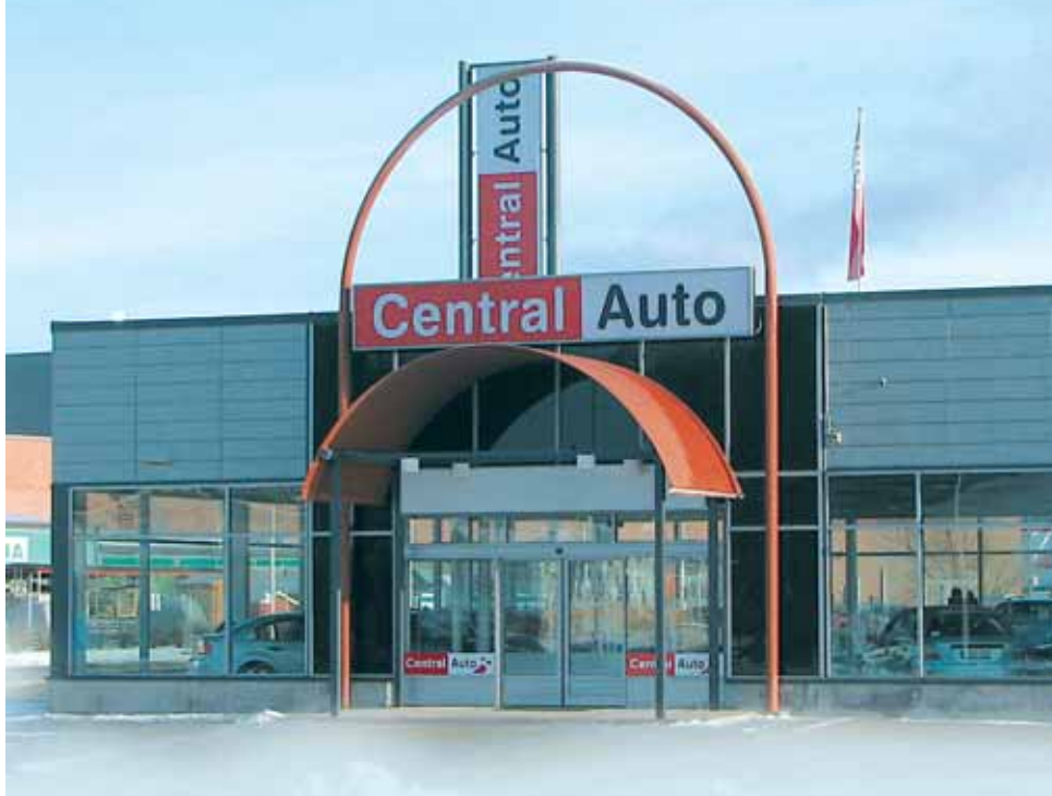
Liiketilän sisäänkäynti Raisiossa Ø 168,3 pyöröputki R-3400 mm
